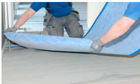
Spärrskiktslaminatet läggs direkt efter det att fästmassan applicerats.
