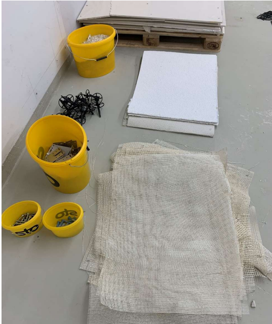
Figur 2. StoVentec konstruktion som har demonterats och delats upp i fraktioner.
