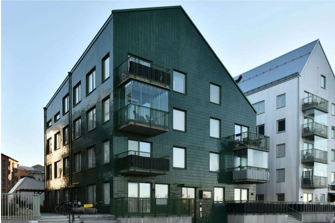
Ett av våra referensprojekt som certifieras med Miljöbyggnad Guld är Kv Neptun i Västerås, färdigställt 2018. Det är det första flerbostadshuset i Sverige som uppförts som plusenergihus. Foto Luc Pagés.
