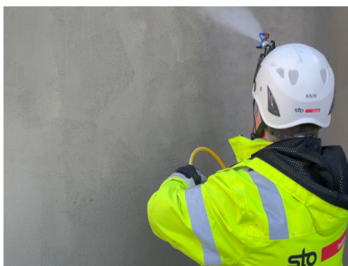
◀ Här appliceras gelen med airless-spruta.
