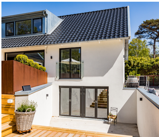
Villa i Helsingborg renoverad med StoNordic, applicerad direkt på mexiteglet som fanns innan.
