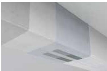
Förstärkning av balk med laminat (StoFRP Plate).
