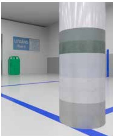
Förstärkning av pelare med väv (StoFRP Sheet).
